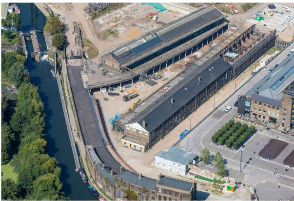
Şekil 1: Coal Drops Yard Restorasyon öncesi [12].
