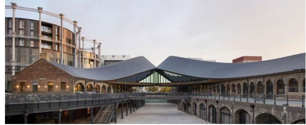
Şekil 2: Coal Drops Yard Restorasyon öncesi (Heatherwick, 2024). Coal Drops Yard, restorasyon projesi ile eklenen çatıların özgün yapılardan gelen doğal eğimi referans olarak tasarlanan kısımları görülmektedir.
