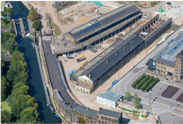
Şekil 1: Coal Drops Yard Restorasyon öncesi [12].
